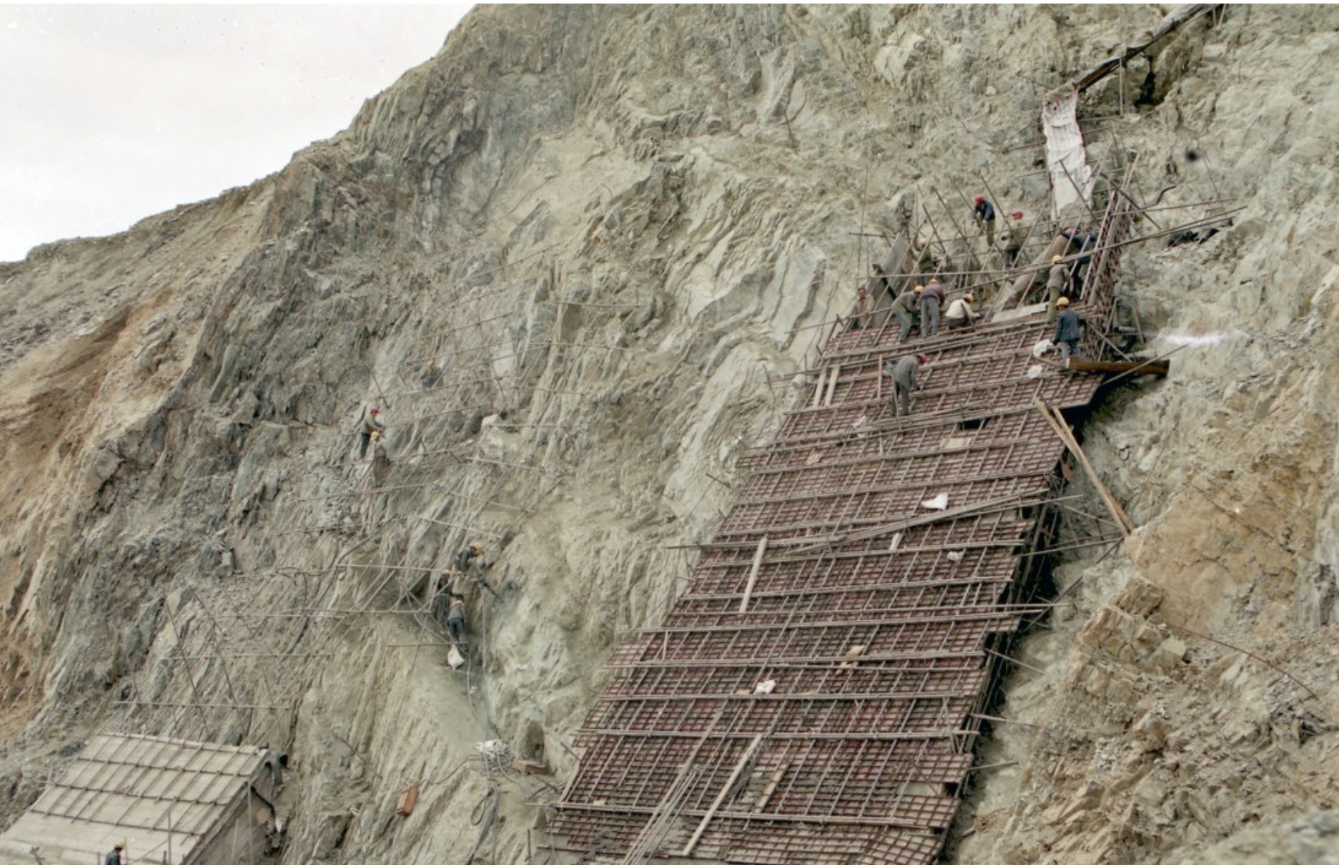
1998年10月,风克干渠渠道高边坡段,施工正在进行挂网支护。
