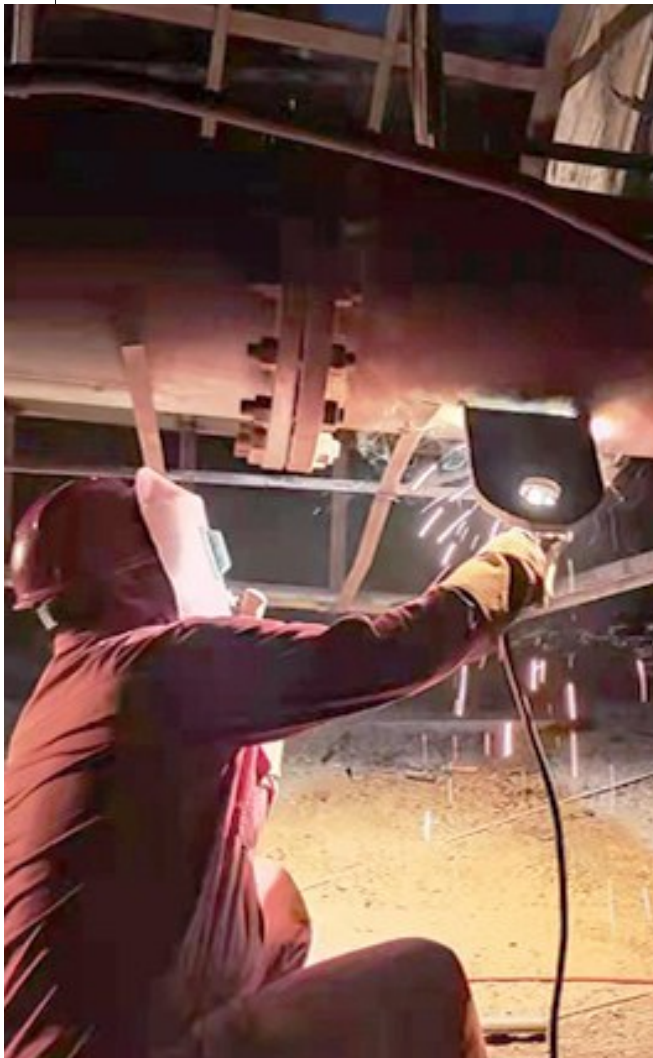
9月26日凌晨2时,该站员工将点火杆高能点火器安装到位,标志着气田气系统改造工程接近尾声。
