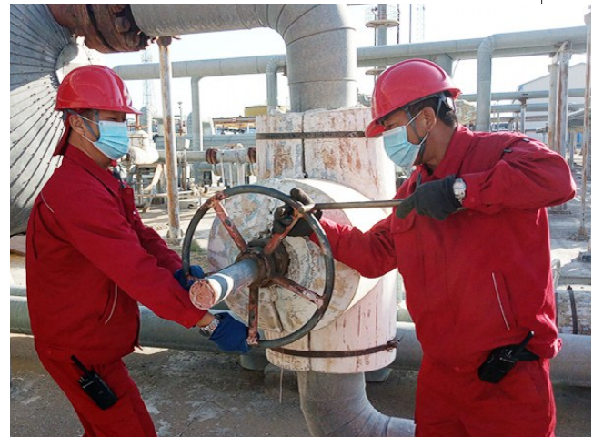
9月27日,该站员工再次检查工艺流程,确认气井进站总阀门处于关闭状态。
