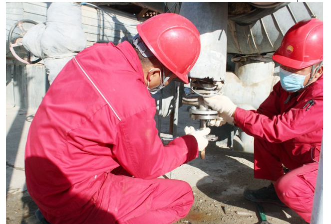
9月27日,该站员工正严格控制进站阀门和节流阀开度,确保气田一次投产成功。
